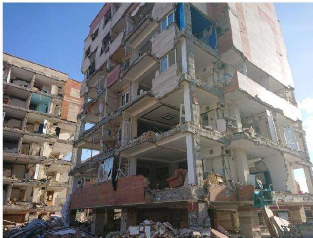
شکل ۲-۵- نمونه ای از آسیب وارده به دیوارهای پیرامونی و پارتیشن‌های داخلی در یکی از بلوک‌ها
