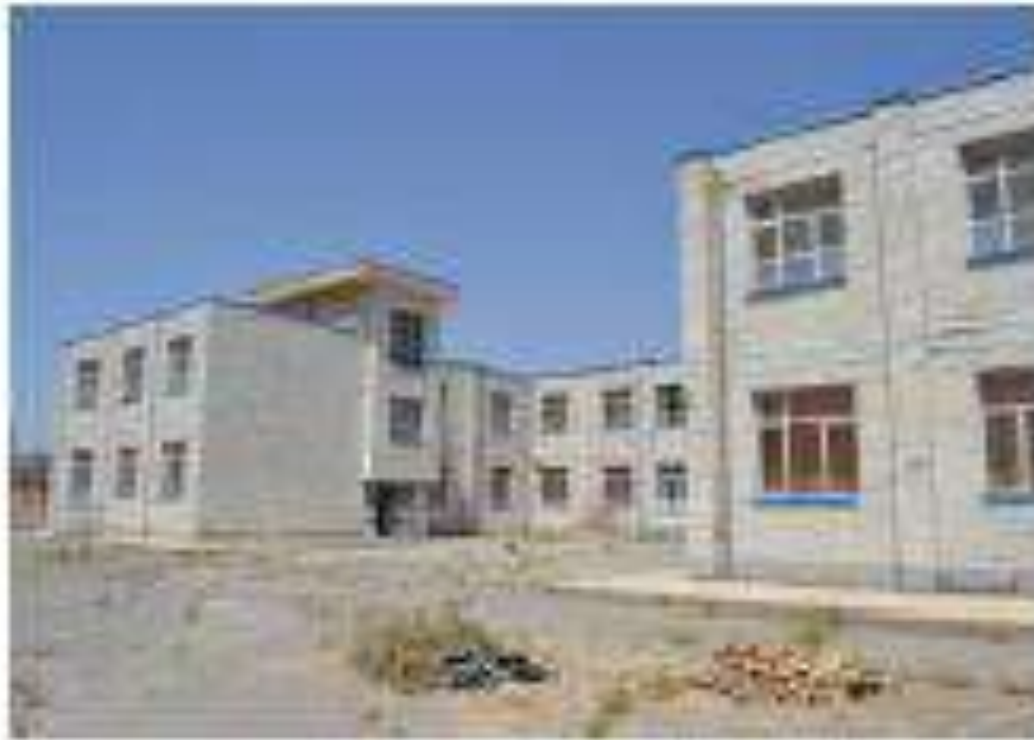
مدرسه مقاوم سازی شده با استفاده از شاکریت
