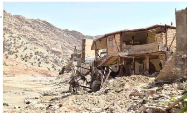
تخریب ساختمانها در حریم رودخانه کشکان رود
