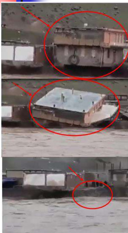
واژگونی و تخریب ساختمان دو طبقه در حاشیه کشکان رود
