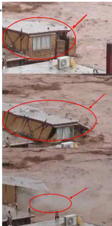
واژگونی و تخریب ساختمان فولادی دو طبقه در حاشیه کشکان رود
