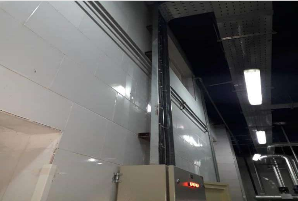
جزئیات اتصال سینی و چراغ زیر سقف موتورخانه
