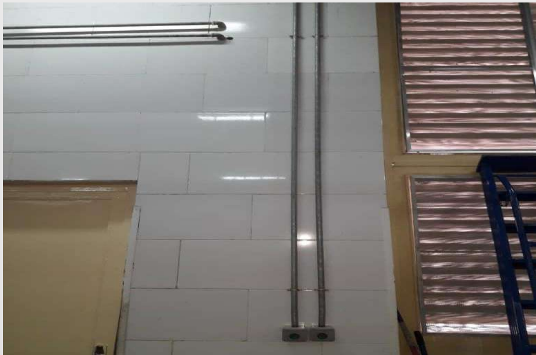
نوله کشی روکار فرمان روشنایی چراغهای موتورخانه
