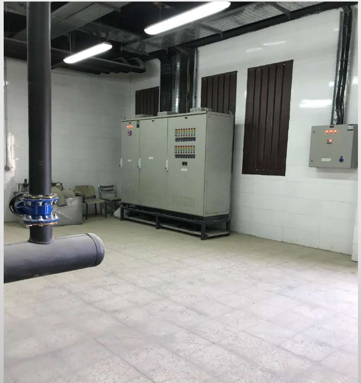
جانمایی تابلو برق موتورخانه
