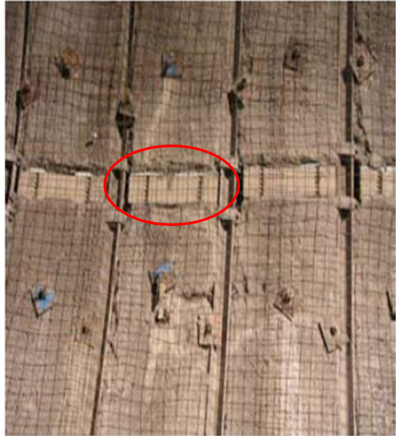
المان های بتنی شکل پذیر که داخل شکاف لاینینگ شات کریت شده قرار دارند.
