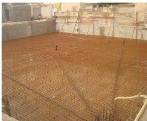
آرماتوربندی فونداسیون گسترده
