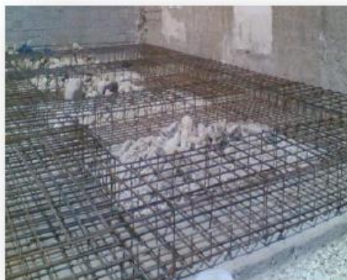
آرماتوربندی فونداسیون نواری
