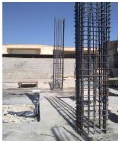
آرماتوربندی ستون بتنی
