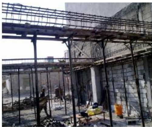
آرماتوربندی تیر بتنی
