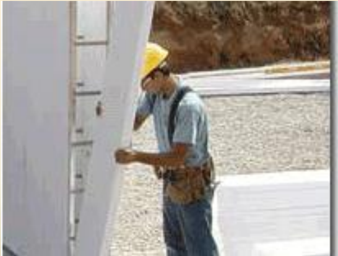
نصب قالبهای عمودی دیوار
