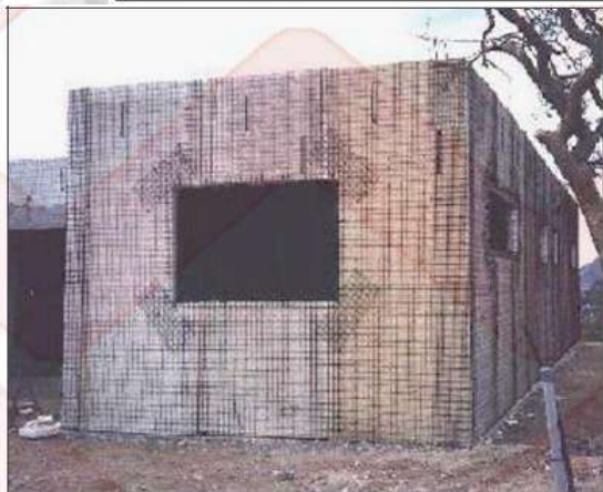
شکل ۳۹ جاگذاری قاب باز شو و تقویت شبکه فلزی
