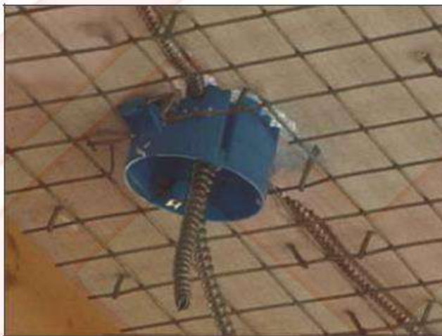
شکل ۴۵ قوطی ها و ترمینال های تاسیسات
