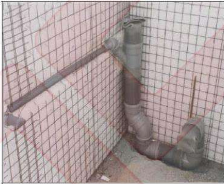
شکل ۴۴ قطع شبکه فلزی برای عبور مدارها و پوشش مجدد آن
