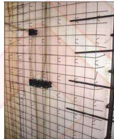
شکل ۴۴ قطع شبکه فلزی برای عبور مدارها و پوشش مجدد آن
