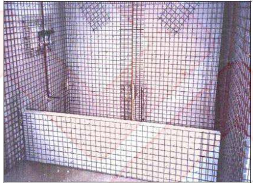
شکل ۴۴ قطع شبکه فلزی برای عبور مدارها و پوشش مجدد آن
