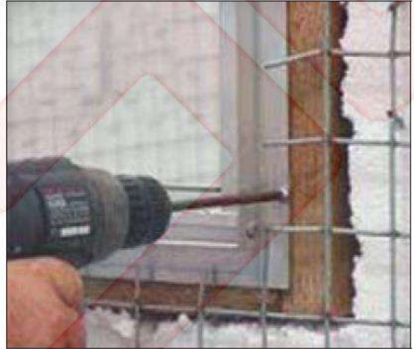
شکل ۳۹ جاگذاری قاب باز شو و تقویت شبکه فلزی
