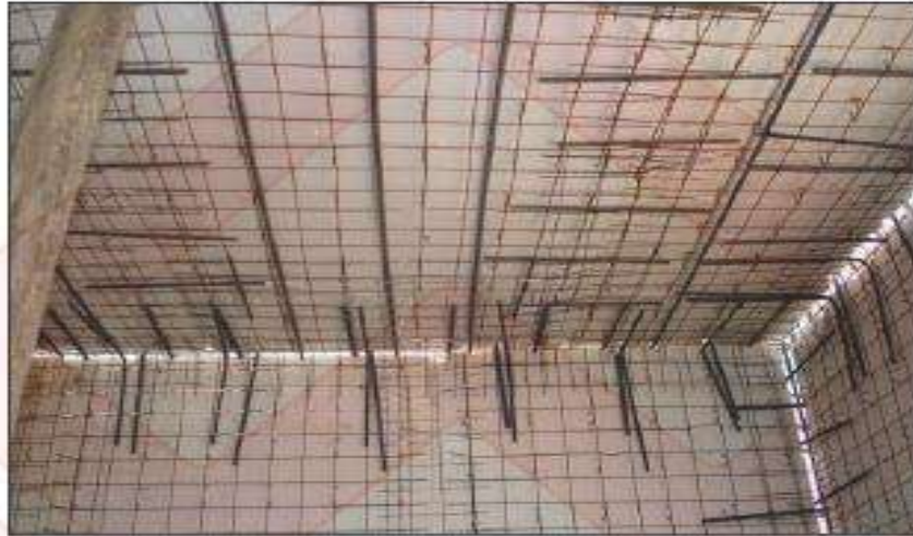
شکل ۱۸ کاربرد شبکه فلزی مضاعف، و میل‌گردها برای تقویت اتصال دیوار و سقف
