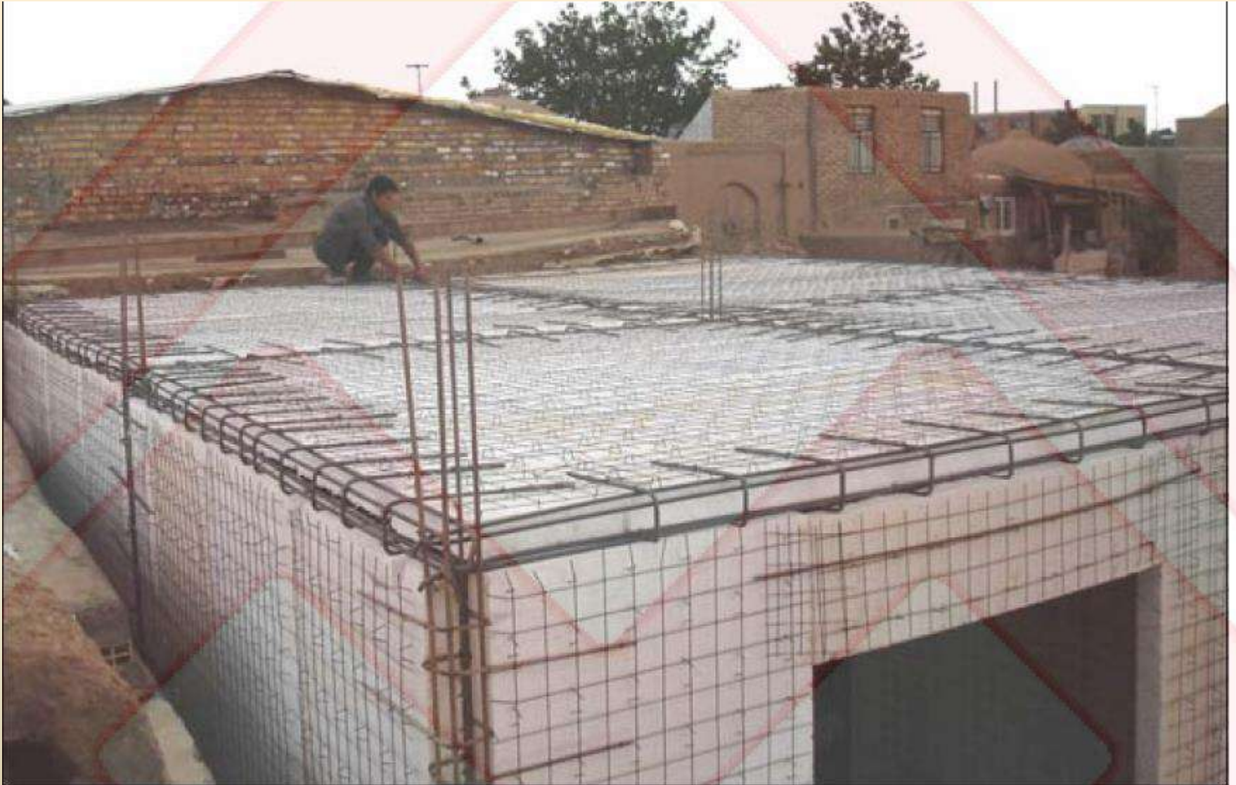
شکل ۷ کلاف بندی دیوار و سقف پانل سه بعدی
