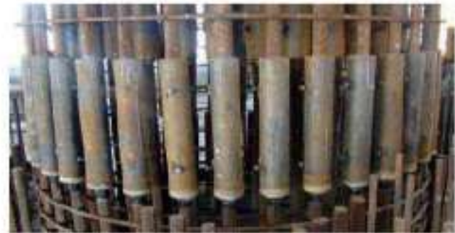
شکل (۱۹) - وصله تزریقی با گروت پر مقاومت
