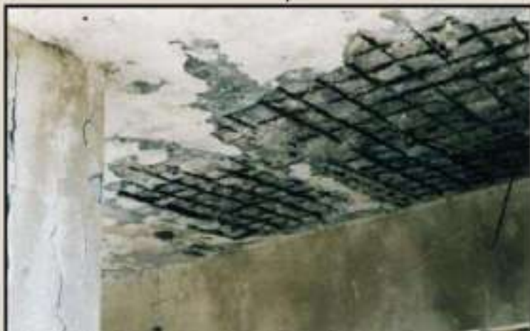
تفریب ناشی از تهاجم کلدایدی در جزیره کیش
