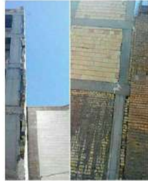
پیر کردن درز انقطاع. همچنین ادامه دادن تیر تا آفر و پیر کردن درز انقطاع به وسیله تیر بتونی
