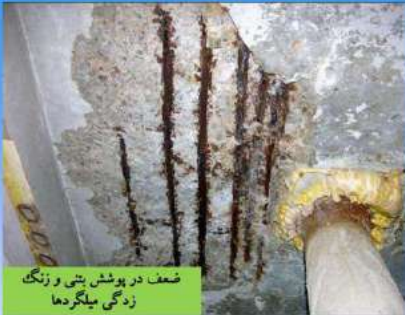
تفریب ناشی از تهاجم کلدایدی در جزیره کیش
