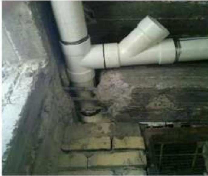
بریدن تیرچه برای عبور لوله تاسیسات فاضلاب
