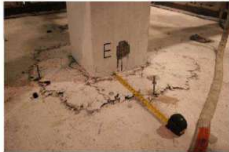
مشکل پانچ (برش مکنه ای) در دالهای تخت (بدون تیر و بدون سرستون)
